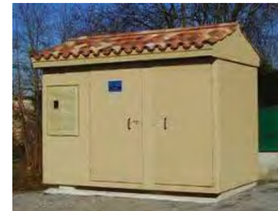
Figure 15 : Illustration du poste de livraison qui sera mis en place sur le projet de Bazac (ABO Wind)
